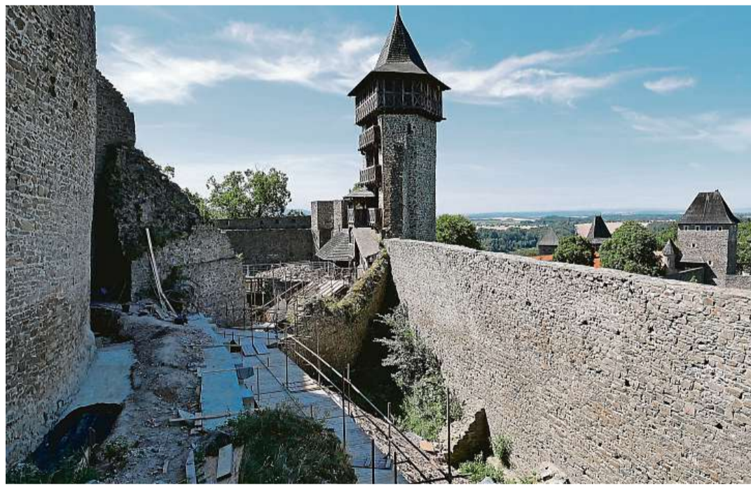
Změny na Helfštýně Kanál objevili archeologové na parkánu renesančního paláce, který právě prochází nákladnou rekonstrukcí. Foto: Zdeněk Schenk, Muzeum Komenského v Přerově
